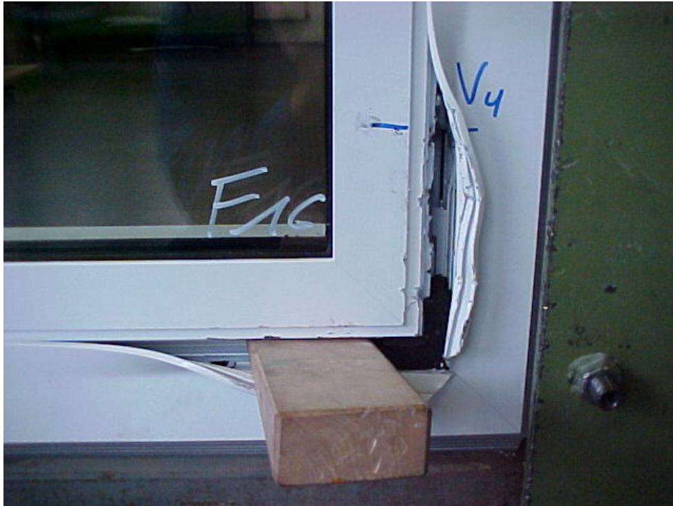
Bild 3 Schäden aus der manuellen Prüfung am Ecklager
